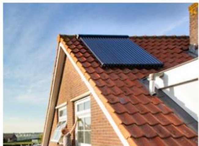
Collector zonneboiler (Bron: www.milieucentraal.nl )
