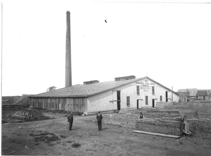
Steenfabriek "De Nijverheid" uit Bedum, 1922. Bron: Groninger Archieven.
